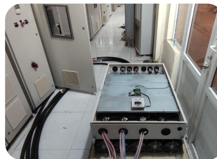
Biến tần GK620 450kW cho nhà máy Mía Đường
