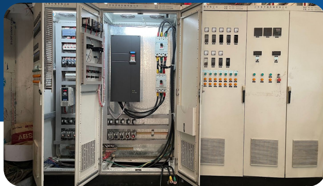
Biến tần Inovance 160kW cho Máy Đùn Nhựa
