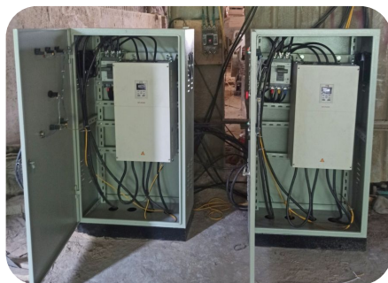
2 Biến tần GK620 90kw/110kw cho Máy Bào Gỗ
