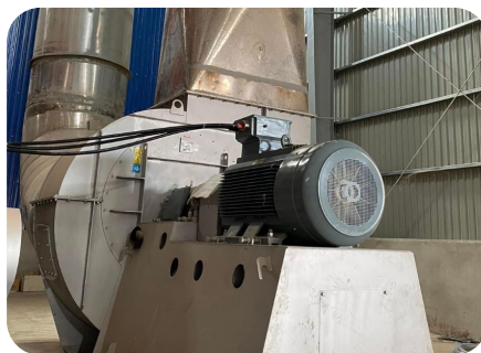
Biến Tần GK620 315kW cho Quạt Hút Ly Tâm
