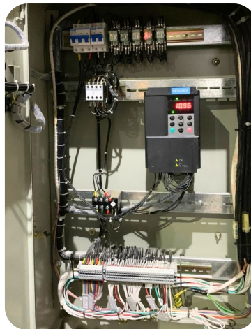
Biến tần Inovance cho máy làm Mát Xi Than
