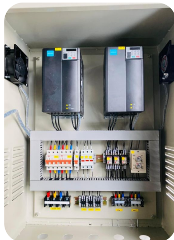
Biến tần MD290 7.5KW cho Quạt Hút Bụi Gỗ
