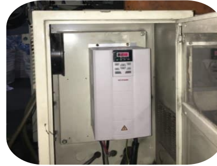
Biến tần 37kW cho Máy Thổi Nhựa
