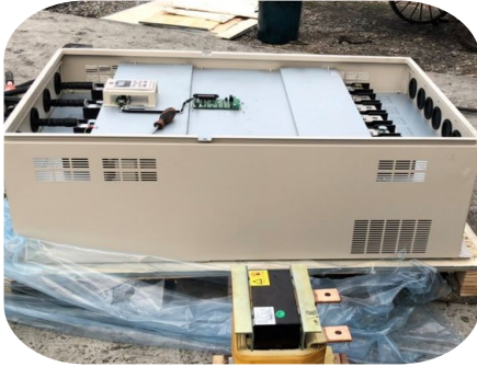
Biến tần 315kW cho Máy Xúc Điện
